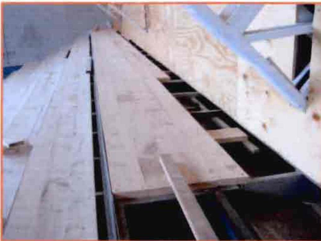
Fotografía 64 – Graderías de estructura de acero y tablones
