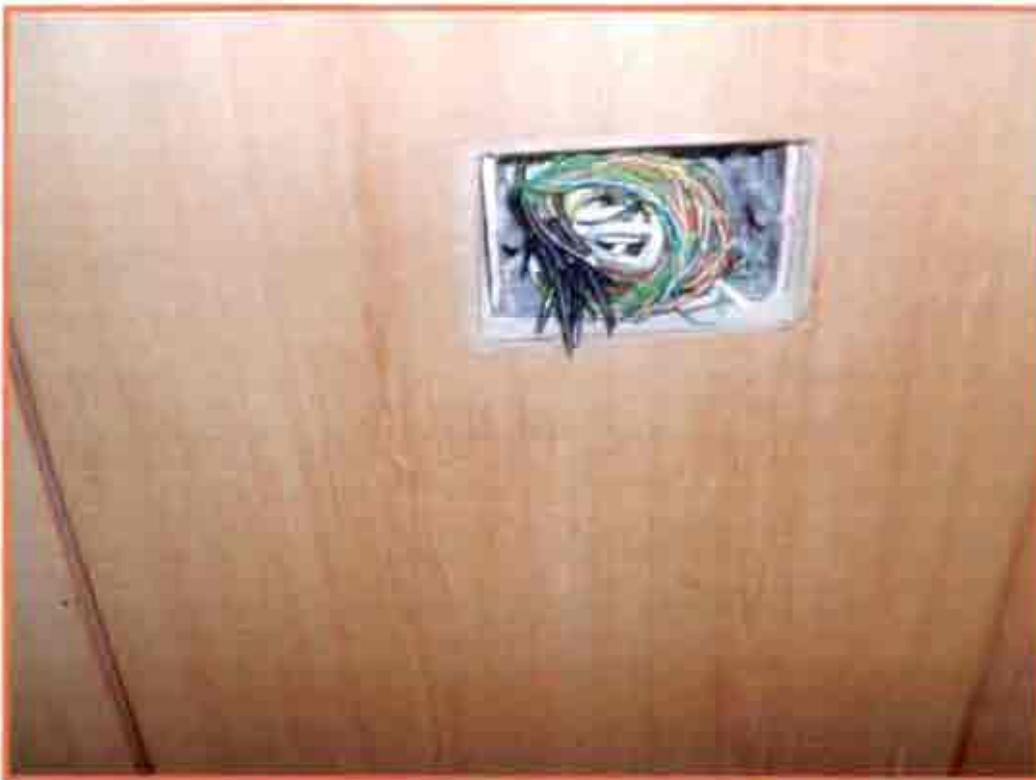
Fotografía 82 – Cajas de derivación
