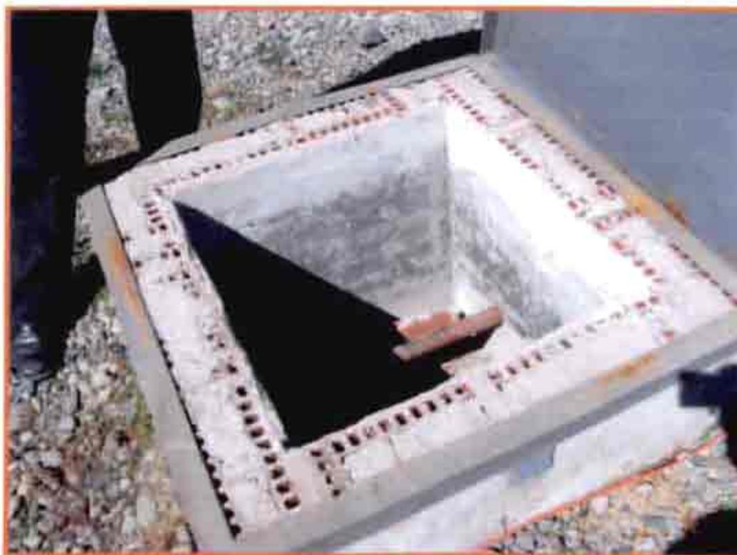
Fotografía 52 – Cámara de inspección
