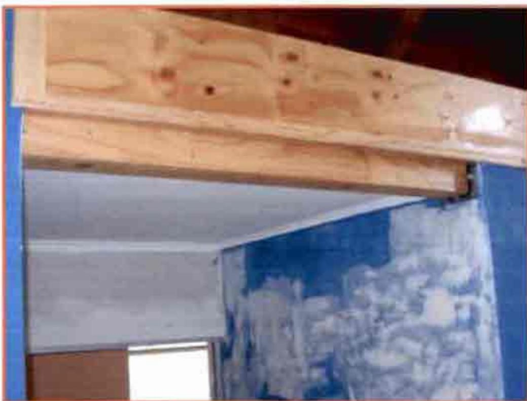
Fotografía 66 – Escenario - Viga metálica revestida en madera
