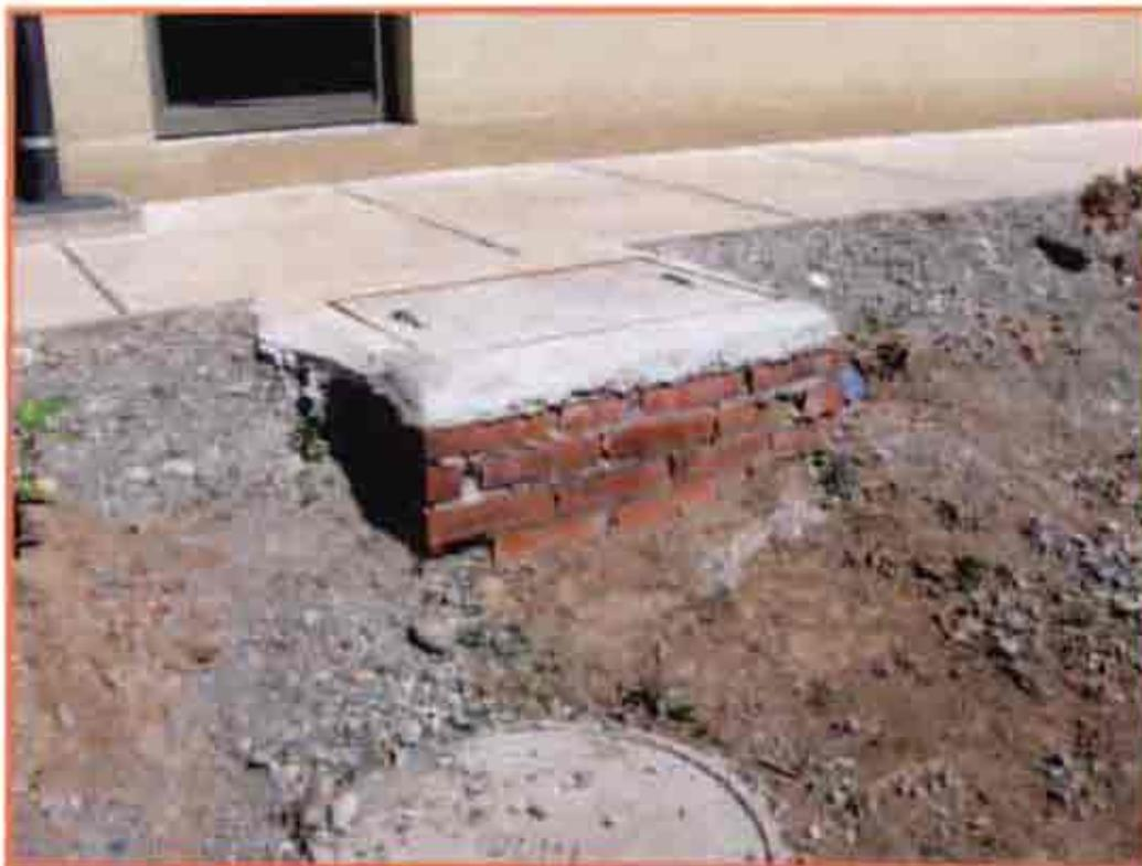
Fotografía 51 – Cámara de inspección
