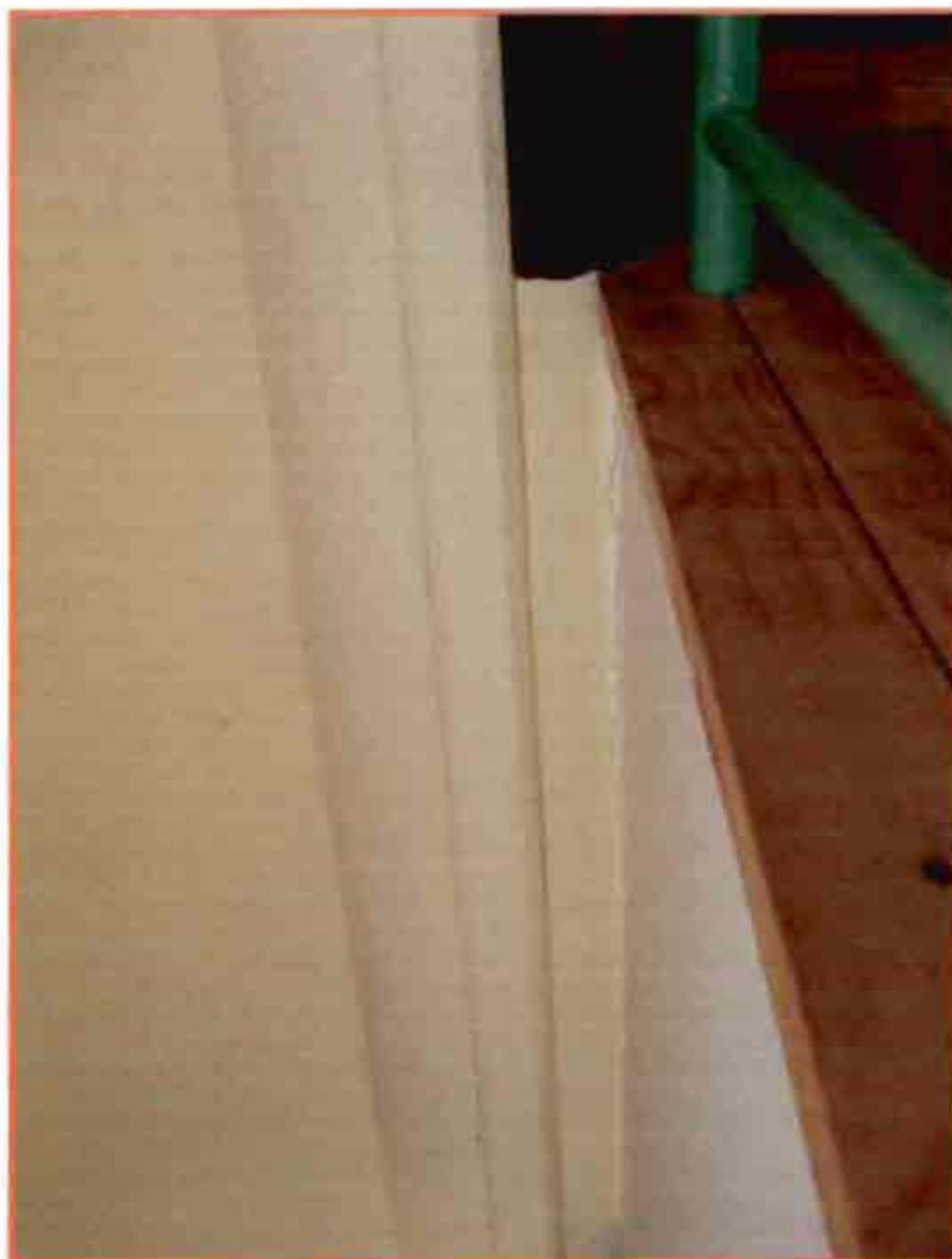
Fotografía 58 – Grietas en pilar estructural
