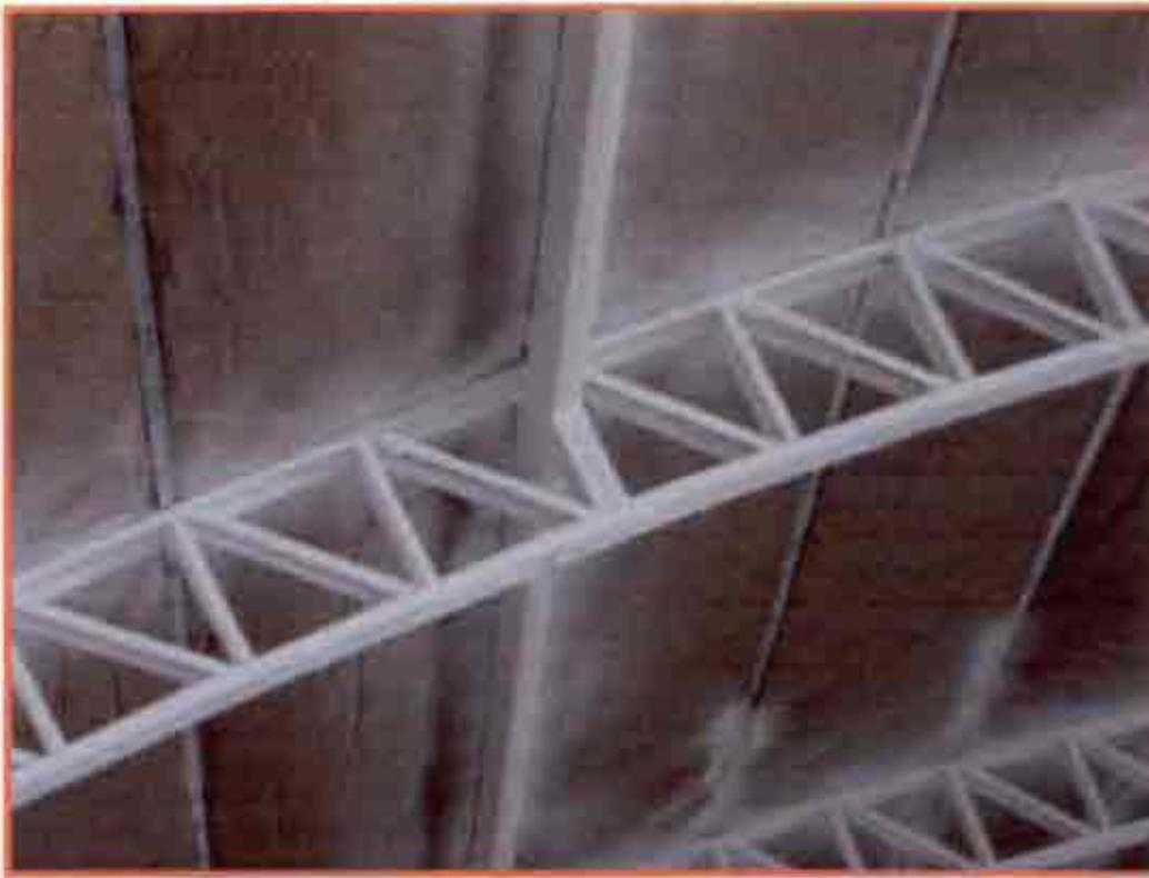
Fotografía 63 – Arco reticulado y viga tubular
