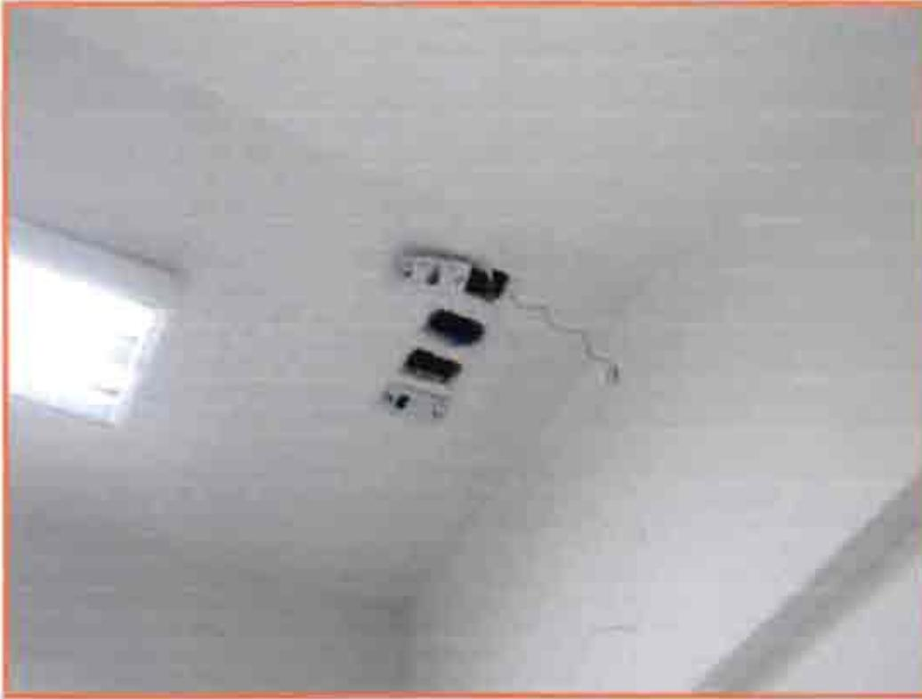
Fotografía 81 – Cajas de derivación
